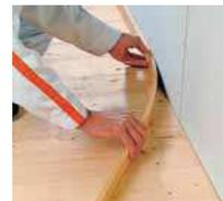
2 - Poser une première rangée de plaques de sol FERMACELL en prenant soin de couper la battue supérieure côté mur. Les plaques doivent présenter en tous points la même épaisseur de matière.
