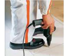
**5 - Visser ensuite les battues l'une sur l'autre, de façon à assurer la compression nécessaire à la parfaite tenue du collage. Les vis peuvent être remplacées par des agrafes spéciales, qui présentent l'avantage de la rapidité.**
